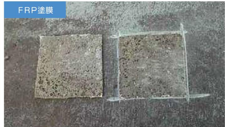
■FRP密着防水のコンクリート躯体内部の水分(スラブ面が濡れている)
