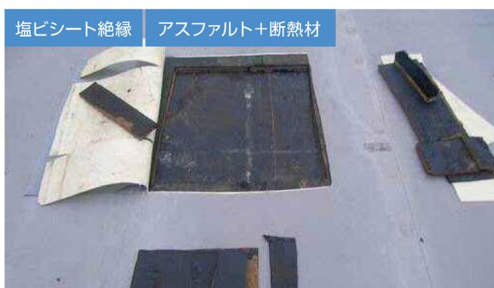
■アスファルト防水(断熱材入り)の上に塩ビシート絶縁防水を施工。
