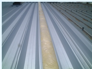
既存金属ハゼ折版に断熱材を入れた、屋根断熱二重葺き
