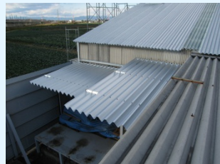
既存金属ハゼ折版に断熱材を入れた、屋根断熱二重葺き
